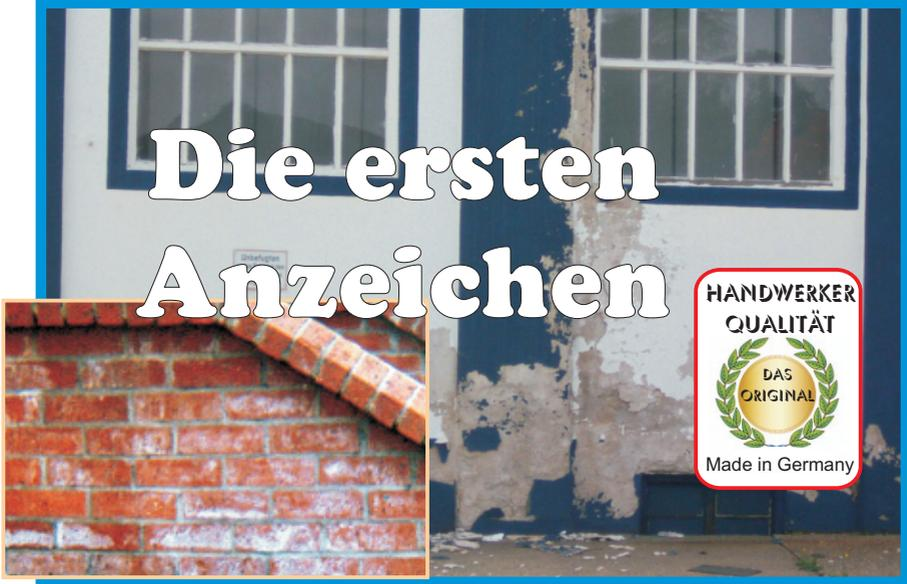
**Feuchtigkeit im Mauerwerk löst Salze**, die beim Verdunsten an der Oberfläche Kristalle bilden und die Kapillare aufweiten. Die Folge ist übermäßige Feuchtigkeitsführung, die zu Salpeter- und Nitrat Ausblühungen führt - erkennbar als weiße Ränder und schimmelartiger, weißer Flaum an der Oberfläche. Dies sind die ersten Anzeichen der drohenden Gefahr des Verfalls.
