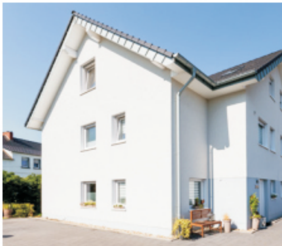
Bild 6.1: Algenfreie Fassade mit Dachüberstand und keiner Bepflanzung
