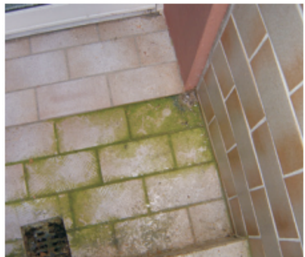
Bild 4: Algenbewuchs im Bereich des Ablaufs eines Kellerabganges
